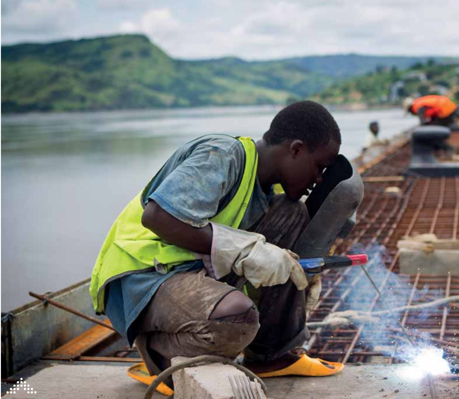
Construction d'un nouveau quai dans le port de Matadi
