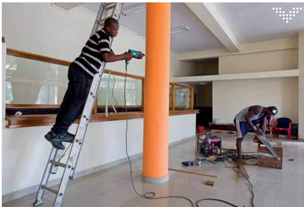
La fin des travaux d'aménagement de la nouvelle agence TMB à Kananga
